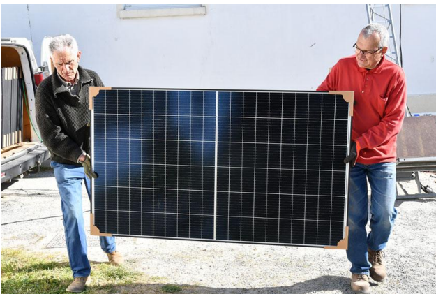
+ Des actionnaires participent au chantier de L'Ecole de Dolus.
