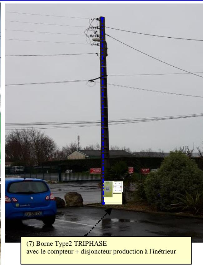
**Raccordement de Type 2 :** Liaison en domaine privé à réaliser par vos soins (La responsabilité d'Enedis s'arrête au niveau du disjoncteur installé en limite de propriété)
